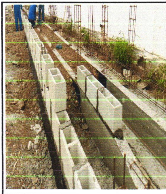
FOTO - 19 Muro em alvenaria bloco
