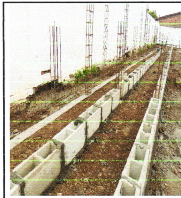
FOTO- 20 Muro em alvenaria bloco
