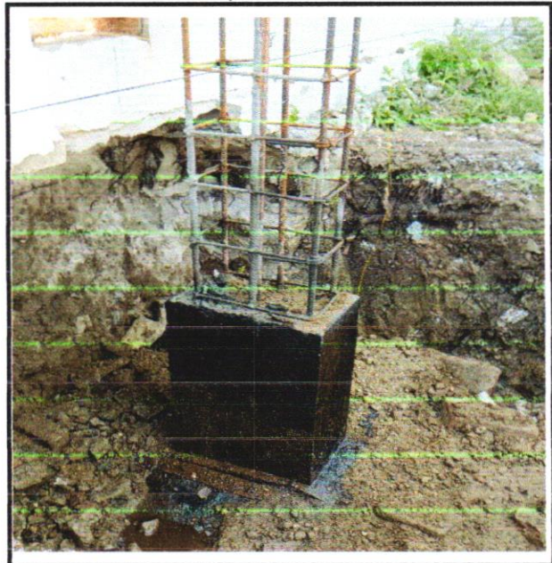
FOTO- 24 IMPERMEABILIZAÇÃO DE SUPERFÍCIE COM EMULSÃO ASFÁLTICA, 2DEMÃOS
