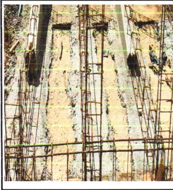
FOTO - 23 IMPERMEABILIZAÇÃO DE SUPERFÍCIE COM EMULSÃO ASFÁLTICA, 2DEMÃOS
