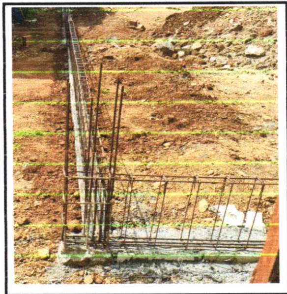
FOTO 15- ARMAÇÃO DE PILAR OU VIGA DE UMA ESTRUTURA CONVENCIONAL DE CONCRETO ARMADO EM UMA EDIFICAÇÃO TÉRREA OU SOBRADO UTILIZANDO AÇO CA-50 DE 8,0 M
