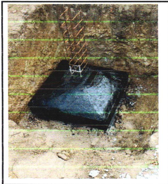
FOTO - 23 IMPERMEABILIZAÇÃO DE SUPERFÍCIE COM EMULSÃO ASFÁLTICA, 2DEMÃOS
